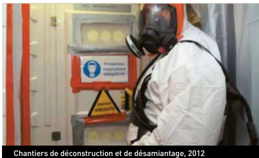
Chantiers de déconstruction et de désamiantage, 2012
